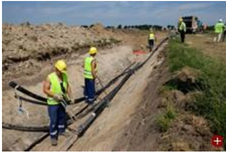
HGÜ-Kabelverlegung an Land
